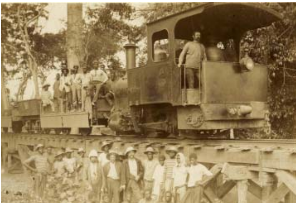
Photo 15 : la construction de la ligne de chemin de fer Matadi-Léopoldville. Bas-Congo, 1894
